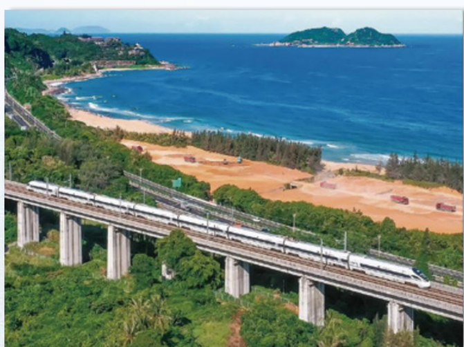
海南环岛高速铁路
