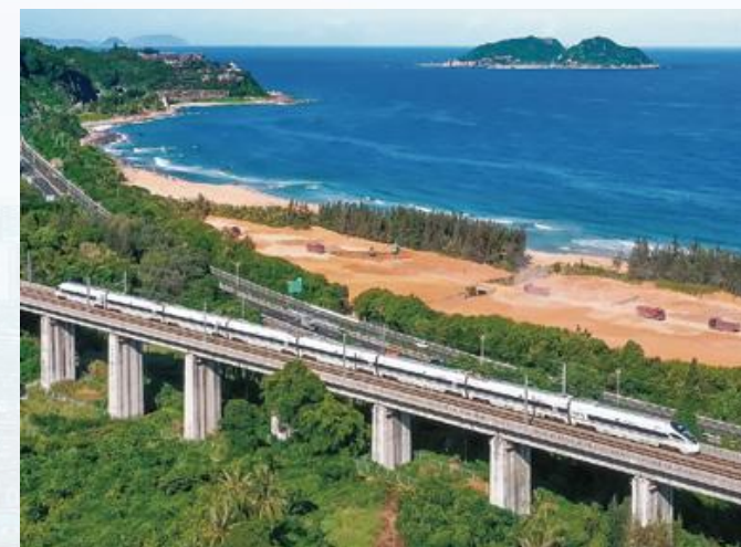
海南环岛高速铁路
