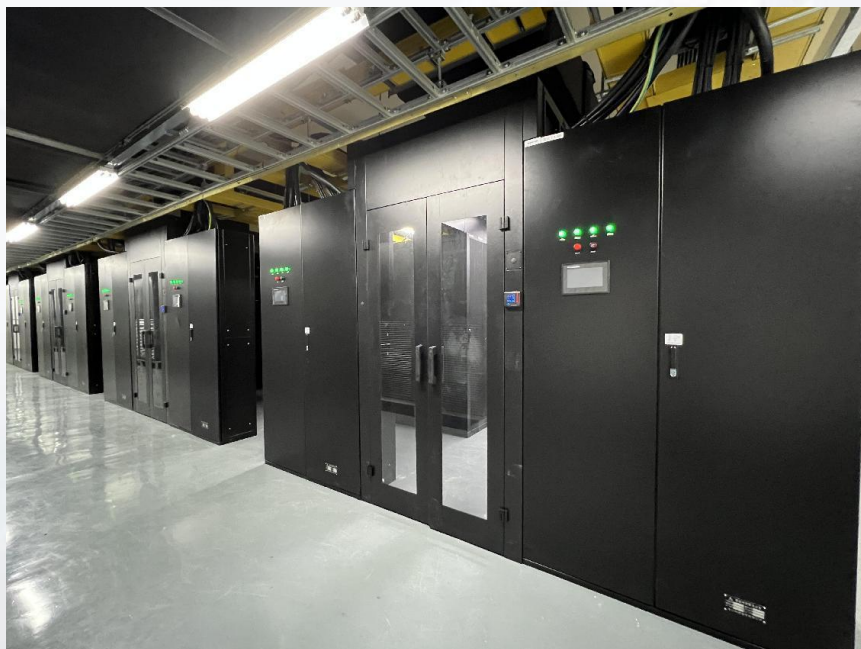
微模块数据中心+半分布式电源
