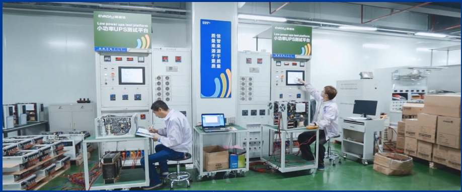
小功率UPS测试
