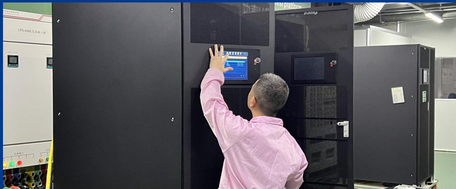
大功率UPS测试
